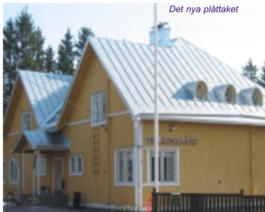
Det nya plåttaket
